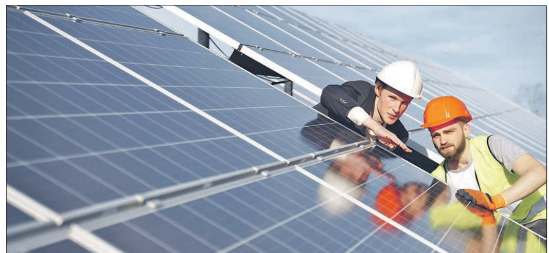
Solaranlagen für saubere Energie.
