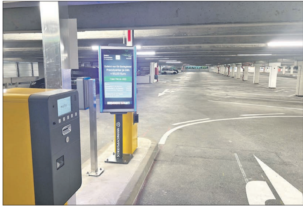
Mit Schranke und digitalem Zugangssystem mit Kennzeichenerkennung an der Ein- und Ausfahrt – das Parkhaus ist nun zum größten Teil wieder in Betrieb. Foto: Stadt
