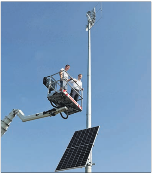
Bürgermeister Dr. Oliver Jedynek (r.) mit einem Mitarbeiter der ausführenden Firma auf dem Hubsteiger Foto: Stadt Bad Homburg
