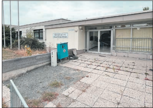
Die ehemalige Maria-Scholz-Schule in Bad Homburg wird in den kommenden Monaten abgerissen. Nach dem Laternenfest wird das Gelände zunächst eingezäunt. Foto: Hochtaunuskreis
