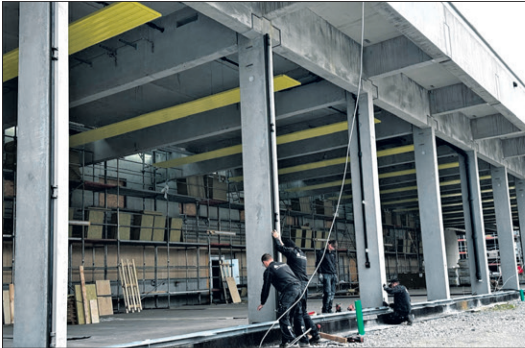
Der Einbau der Tore erfordert höchste Präzision.
