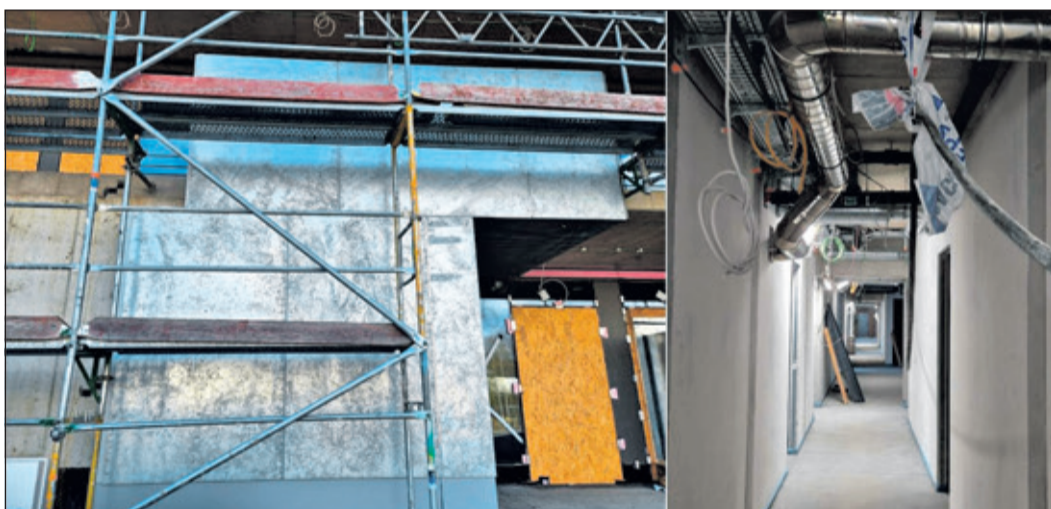
An der Seitenfront kann man schon ein Muster der feuerverzinkten Metallfassade sehen. Die Arbeiten im Innern der Wache laufen planmäßig.
