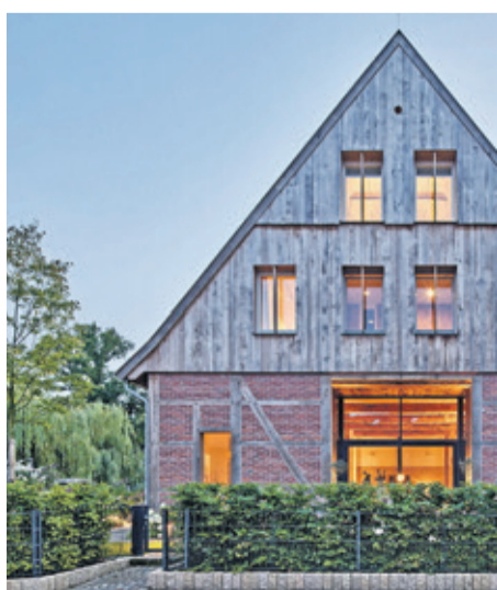
Bei der Sanierung historischer Fassaden, wie hier an einemw Bauernhof in Münster, ist viel Fachwissen gefragt. Foto: DJD/Brillux
