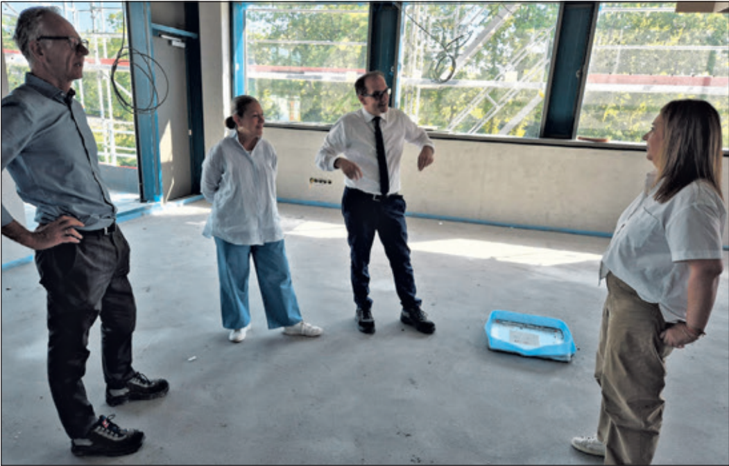
Projektleiterin Corina Kaiser (r.) freut sich über den fertig gelegten Estrich und erläutert Details an (v.l.) Fachbereichsleiter Michael Serba, Abteilungsleiterin „Gebäude und Liegenschaften“ Dorothea Reidel und Bürgermeister Dr. Frank Blasch. Foto: Stadt Bad Soden
