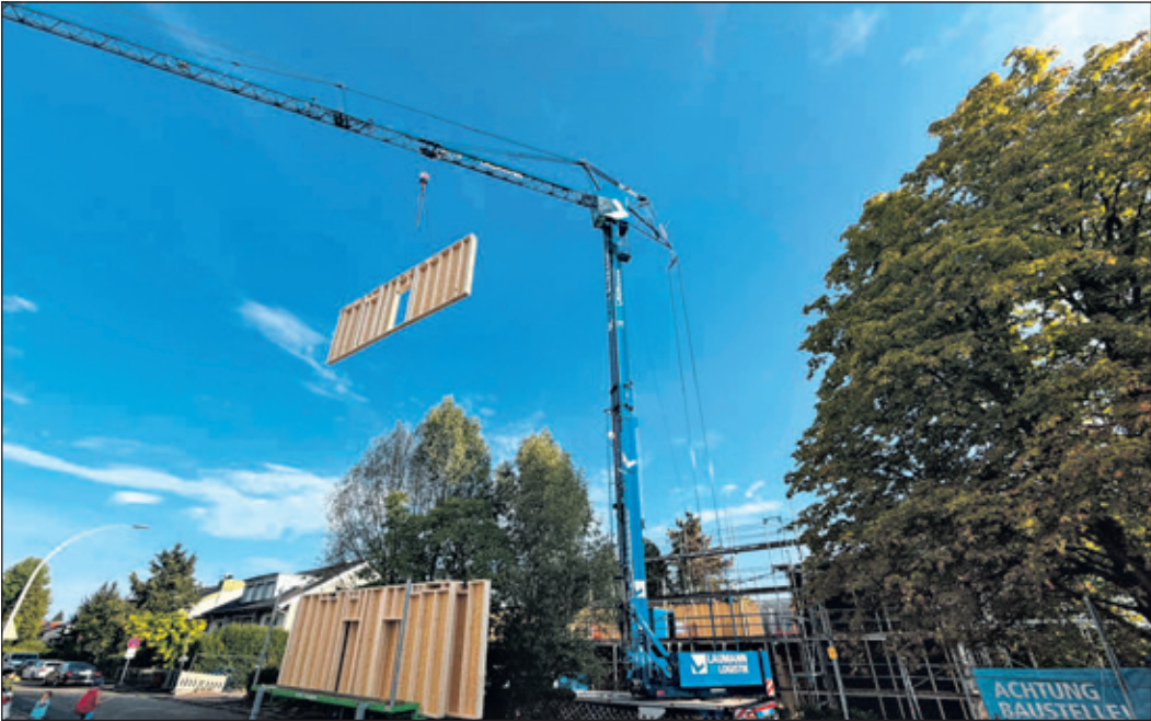
Nach und nach werden die Holzmodule mit einem Kran auf das Gelände der Kita Sonnengarten gehoben und ins Obergeschoss eingepasst. Foto: Stadt Bad Soden
