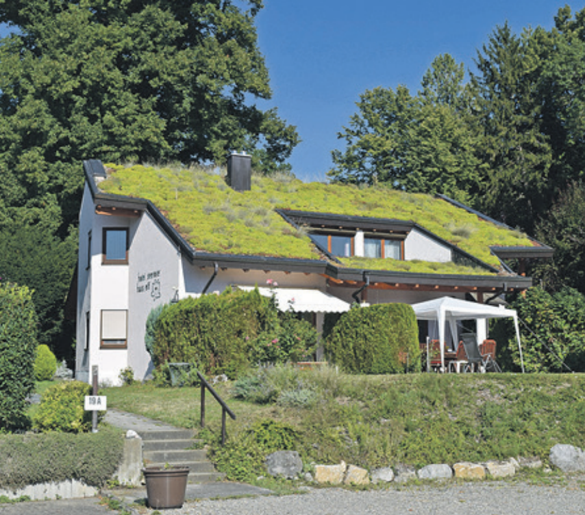
Dachbegrünungen tragen zum Klimaschutz bei: Sie binden CO 2 in der Vegetation und helfen durch Energieeinsparungen, Emissionen zu senken.
