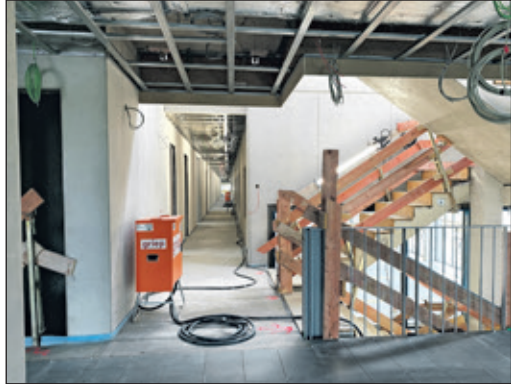
Blick ins Treppenhaus
