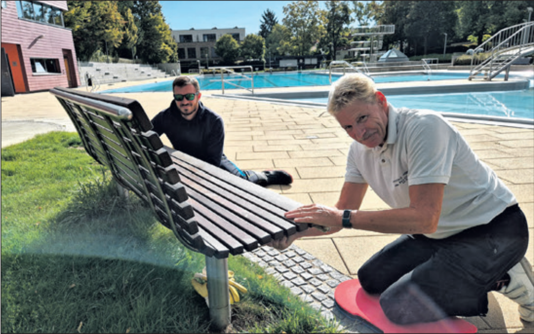
Jrg Esch und Markus Gilcher im Reparatereinsatz. Foto: Stadt Bad Soden
