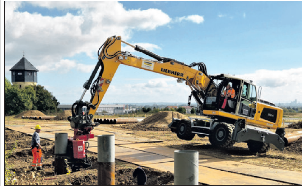
Derzeit laufen die Vorbereitungen für eine Lärmschutzwand für das neue Wohngebiet Sinai II + III. Foto: Stadt Bad Soden
