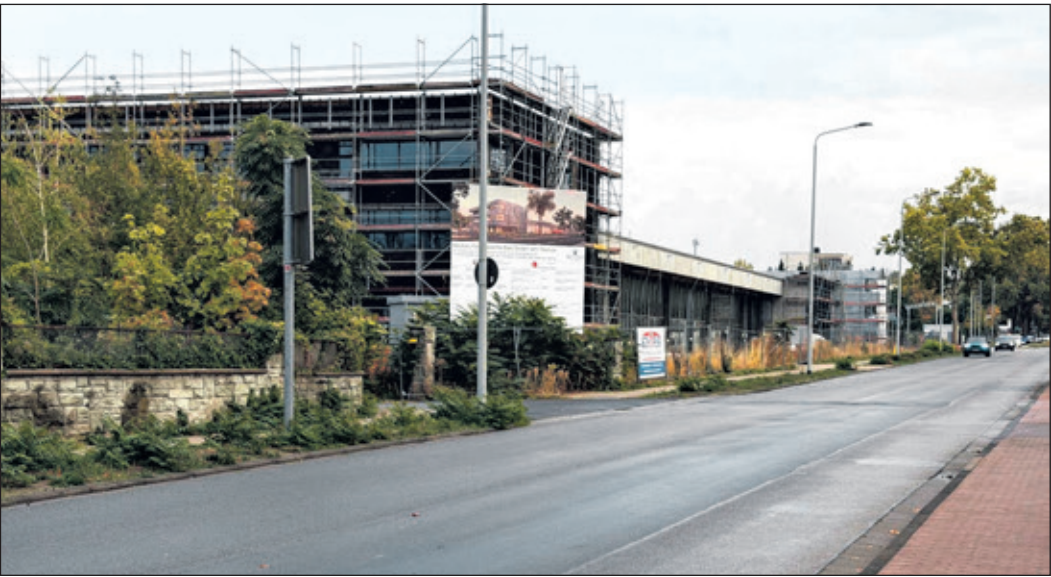
An der Königsteiner Straße werden Gehwege, Grün- und Fahrradstreifen angelegt. Foto: Stadt Bad Soden
