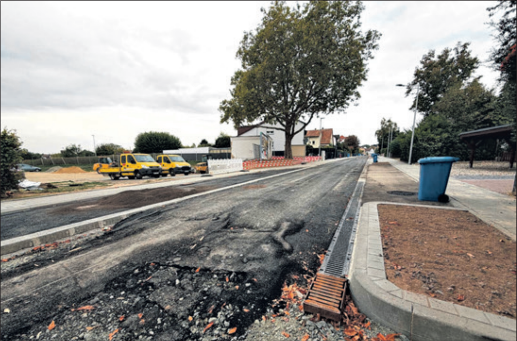
Die Sanierung im ersten Bauabschnitt ist abgeschlossen, in der kommenden Woche wird noch die Deckschicht aufgetragen. Foto: Stadt Bad Soden
