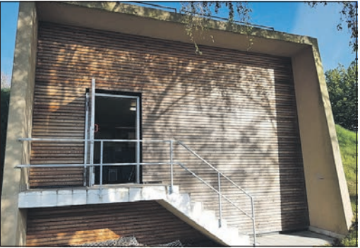
Auch der „Wasserhochbehälter V“ in Eschborn muss in den nächsten Jahren saniert werden. Foto: WBV
