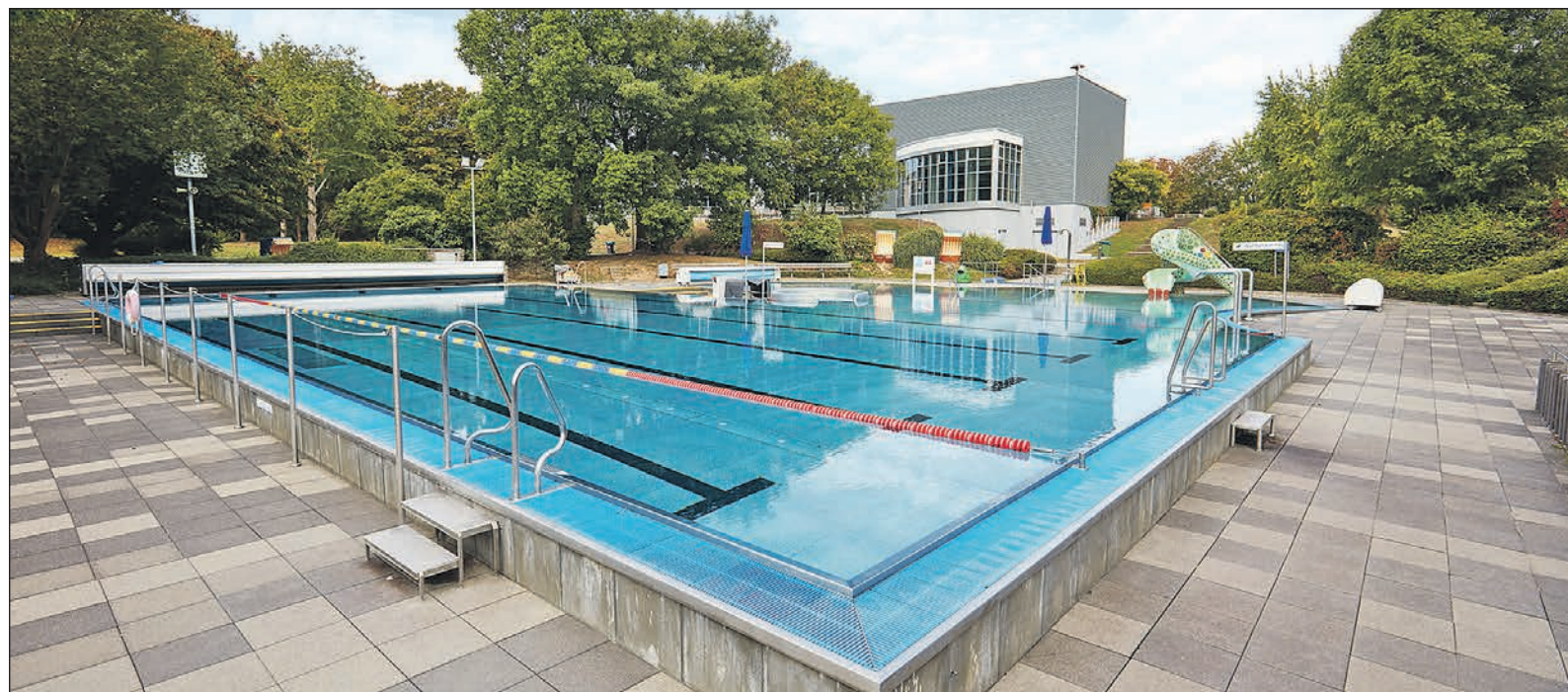
Nichts geht mehr zurzeit im Eschborner Wiesenbad. Seit fast vier Wochen ist die Anlage wegen eines Befalls mit Legionellen geschlossen. Die Stadt hofft, das Bad Mitte April wieder in Betrieb nehmen zu können. Archivfoto: Stadt Eschborn
