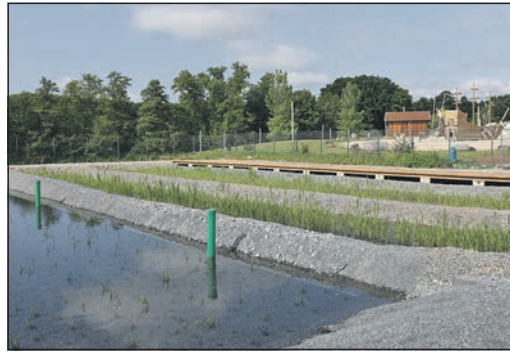
Das Regenerationsbecken wurden aufwändig erneuert. Foto: Stadt Schwalbach
