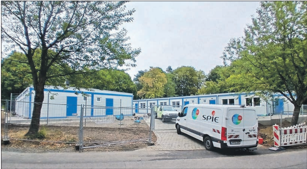
Die neue Container-Anlage für Geflüchtete mit Bleiberecht neben dem Eschborner Friedhof ist so gut wie fertig. Foto: Schlosser
