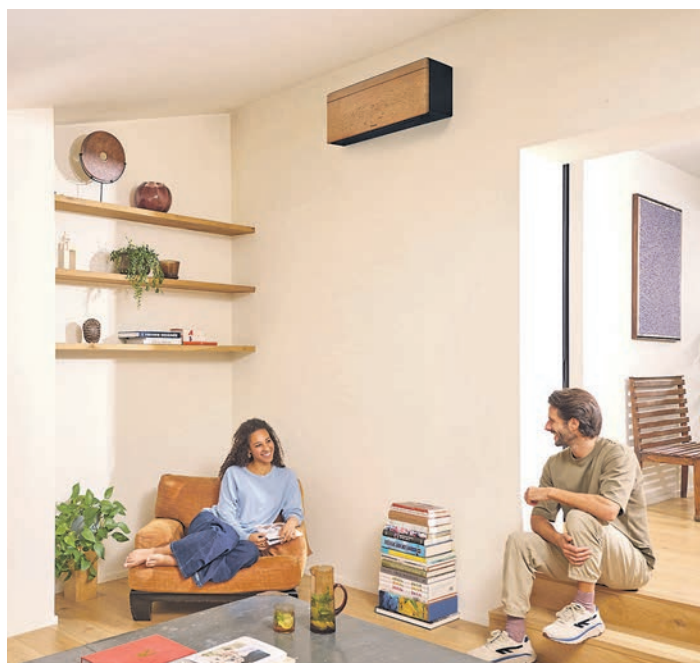
Kühlen Kopf behalten: Klimaanlagen sorgen an heißen Tagen für angenehme Temperaturen im Zuhause. Foto: DJD/DAIKIN
