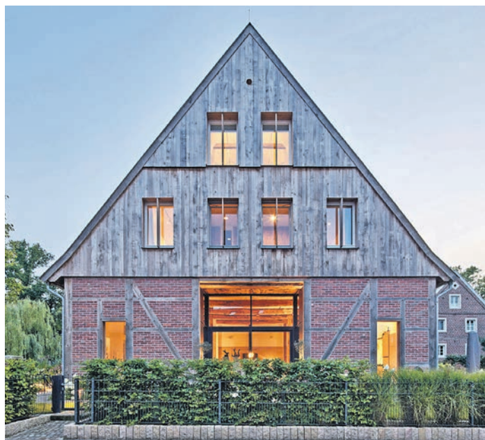
Bei der Sanierung historischer Fassaden, wie hier an einem Bauernhof in Münster, ist viel Fachwissen gefragt. Foto: DJD/Brillux
