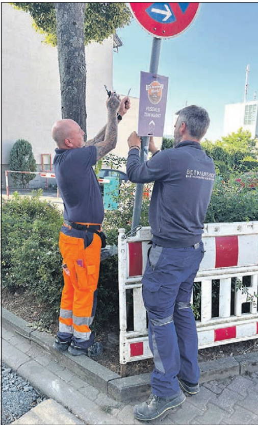
Mitarbeiter des Betriebshofs hängen die Wegweiser zu den Märkten im Gluckensteinweg auf. Foto: Stadt Bad Homburg
