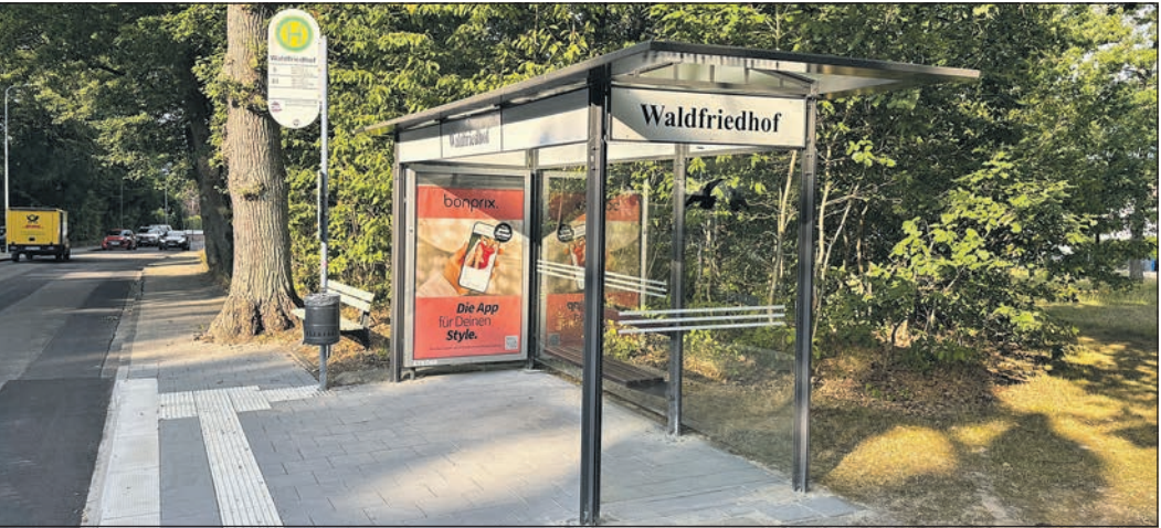
Komfortabler ein- und aussteigen: Mit dem kontinuierlichen Ausbau der Bushaltestellen verbessert die Stadt Bad Homburg den Zugang zum öffentlichen Nahverkehr. Foto: Stadt
