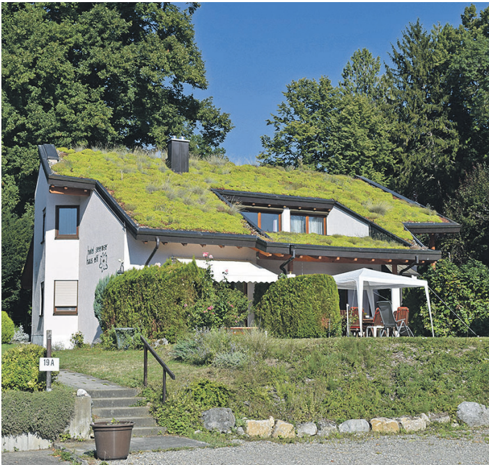
Dachbegrünungen tragen zum Klimaschutz bei: Sie binden CO 2 in der Vegetation und helfen durch Energieeinsparungen, Emissionen zu senken. Foto: DJD/Bundesverband GebäudeGrün
