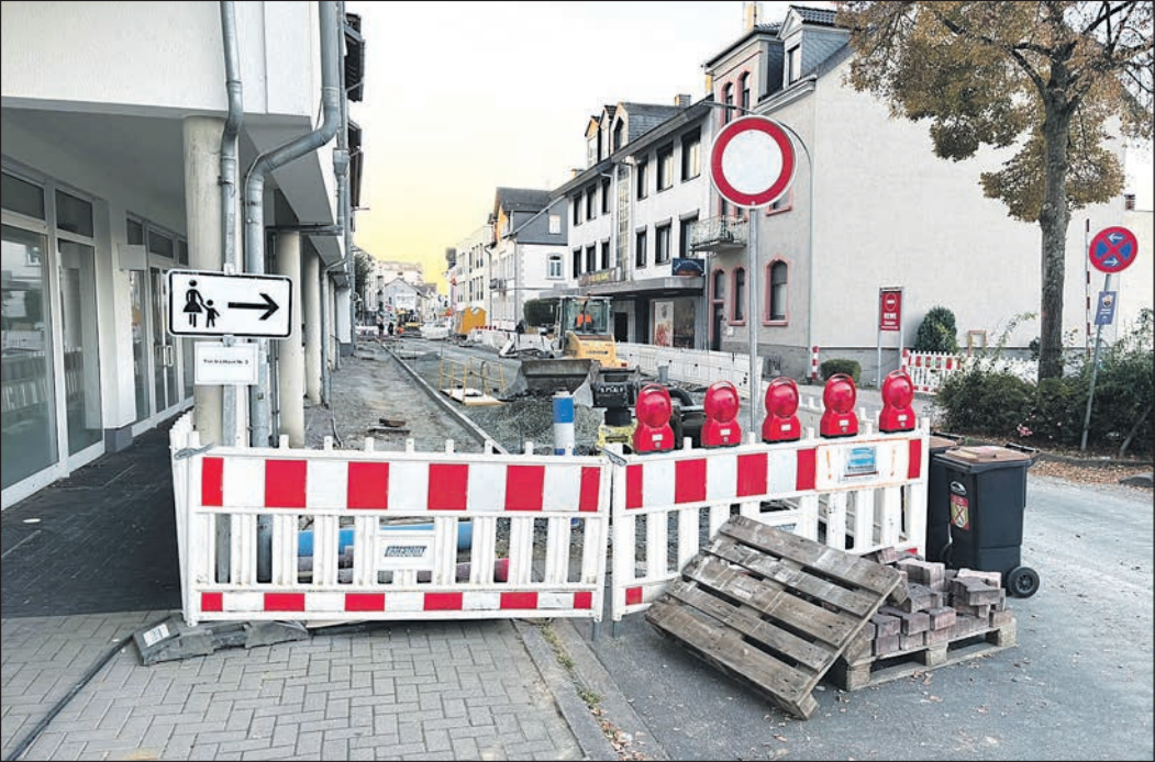
Nach der Baustelle ist vor der Baustelle: Im nächsten Bauabschnitt Richtung Schwalbacher Straße geht es nahtlos weiter. Foto: Stad Bad Homburg
