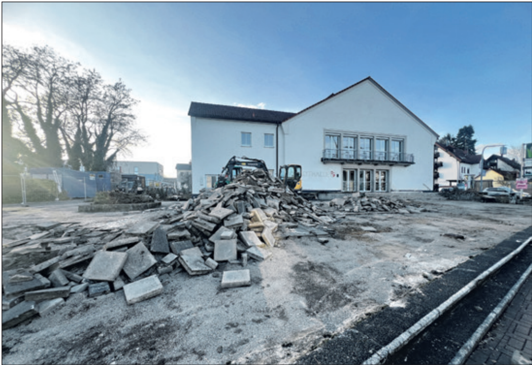
Momentan sieht es eher chaotisch vor der Stadthalle aus. Inzwischen haben die Bauarbeiter Strippen gespannt, anhand derer man erahnen kann, wohin die Reise geht. Foto: J. Ulbricht
