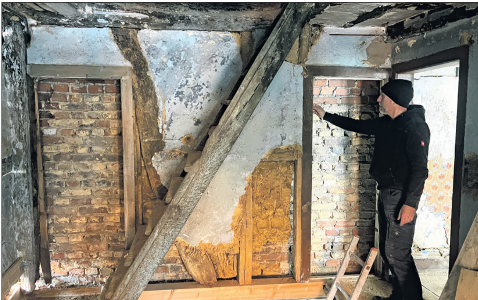
Der Sanierungsexperte Andreas Friedrich hat das denkmalgeschützte Haus am ehemaligen Untertor in der Kelkheimer Altstadt übernommen, nachdem es zuvor lange Zeit leer gestanden hatte. Mit der Sanierung erwacht das alte Haus aus seinem Dornröschenschlaf. Hört man Friedrich zu, entstehen aus seinen Worten Bilder, das Haus nimmt Gestalt an. Für das ehemalige „Geisterhaus“ ist das kein Spuk, sondern ein echter Glücksgriff. Fotos: Judith Ulbricht
