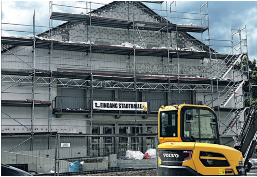
Momentan ist die gute Stube der Stadt kaum wiederzuerkennen. Gerüste, kahle Außenfassade, Bagger und Materialsäcke bestimmen das Bild. Doch mit ein bisschen Fantasie kann man sich jetzt schon vorstellen, was am Ende entsteht.
