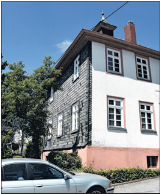
Der Denkmalschutz hatte ein Auge drauf, jetzt strahlt das Alte Rathaus in Eppenhain mit neuen Fenstern Foto: Ingo Baumgartl
