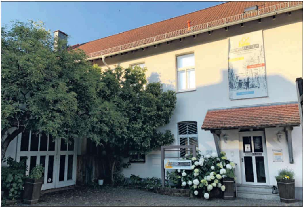
Der Eingang des Museums ist im Zuge der Umbauarbeiten auf die andere Seite in den Schwarzen Weg verlegt worden. Dort ist auch ein Fahrstuhl entstanden, der Besucher barrierefrei in das obere Stockwerk befördert.
