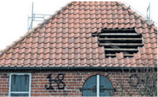
Altbau mit Sturmschaden: Eine fehlende Windsogsicherung kann bei älteren Dächern häufig zu Sturmschäden führen. (Foto: epr/Friedrich Ossenberg-Schule)
