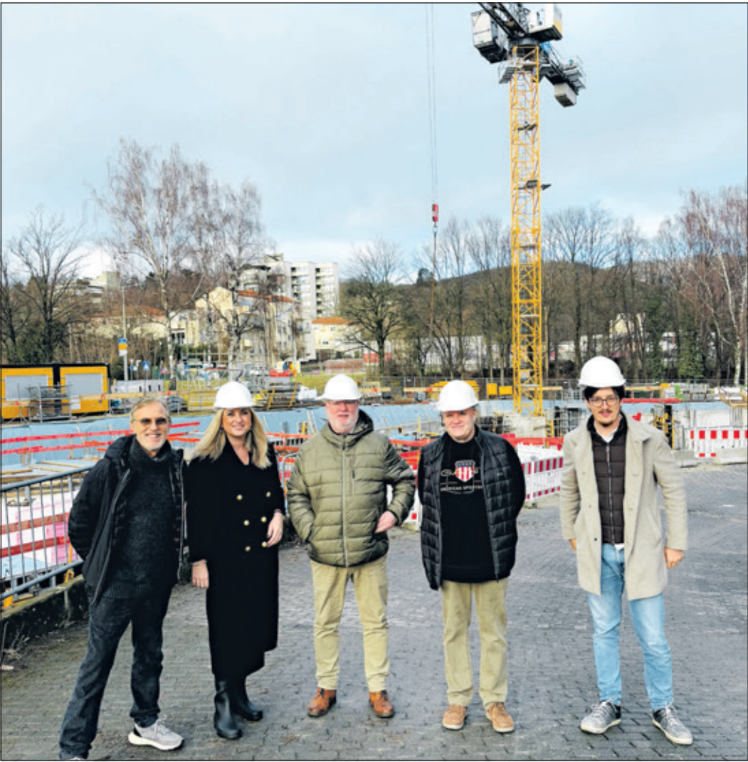
Im Rahmen eines Vor-Ort-Termins besichtigten Bürgermeisterin Beatrice Schenk-Motzko und Erster Stadtrat Jörg Pöschl kürzlich den aktuellen Bauabschnitt auf der Baustelle der neuen Behlke-Firmenzentrale. Dabei informierten sich die Beteiligten am Kreisel über den Stand der Arbeiten, die nächsten Umsetzungsschritte sowie den weiteren Zeitplan. Der Baufortschritt entspricht dem geplanten Ablauf – wer häufiger die Baustelle passiert, kann sehen, wie schnell der Neubau in die Höhe wächst. Der regelmäßige Austausch vor Ort dient der transparenten Begleitung des Projekts und der Sicherstellung eines reibungslosen Bauablaufs. Foto: Stadt Königstein
