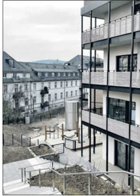
Die Treppe vom hintersten Teil der Höfe zur Soder Straße ist noch nicht geöffnet.
