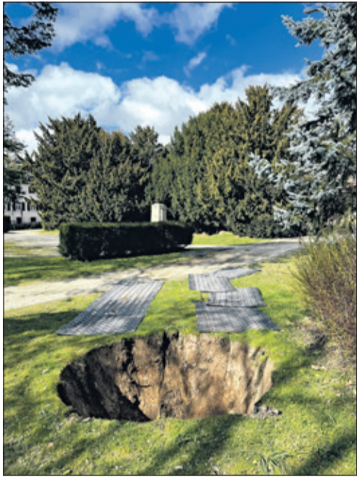
Rund drei Meter Durchmesser hat das Baumloch, das der Rundspaten ausgestochen hat.
