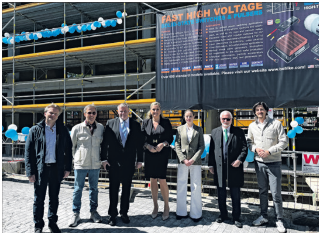
Blickten beim Richtfest gemeinsam optimistisch in die Zukunft (v.l.): Hubertus Dreßler (Geschäftsführer Dreßler Bau), Architekt Eberhard Horn, Frank Behlke, Bürgermeisterin Beatrice Schenk-Motzko, Jennifer Behlke, Stadtverordnetenvorsteher Michael-Klaus Otto und Architekt Florian Horn. Fotos: Schramm
