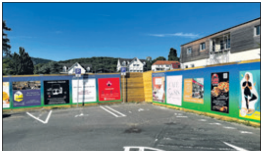
Schaufenster für Gewerbe: der Bauzaun an P1
