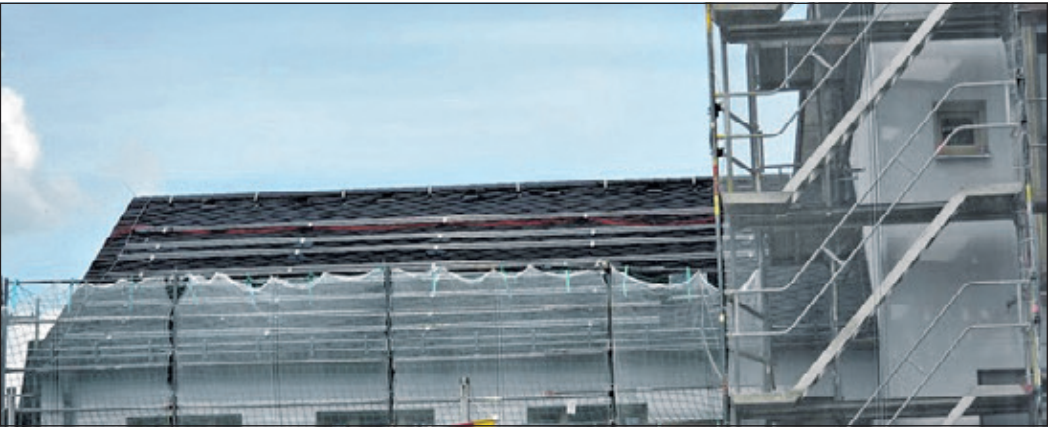
Die Vorbereitungen am Dach zeigen eindeutig: Hier wird bald eine Photovoltaikanlage installiert. Foto: privat
