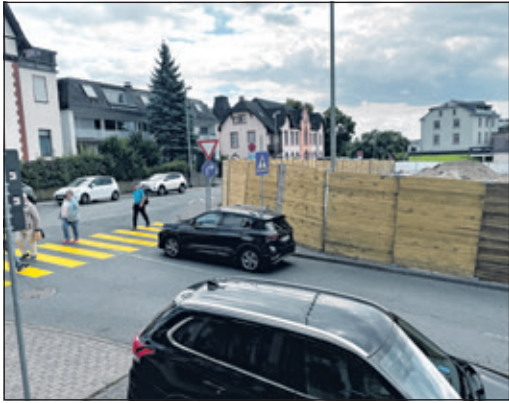
Der vom Bauzaun verengte Gehweg in der Klosterstraße wurde gesperrt, der Zebrastreifen liegt jetzt im Kreuzungsbereich. Foto: as
