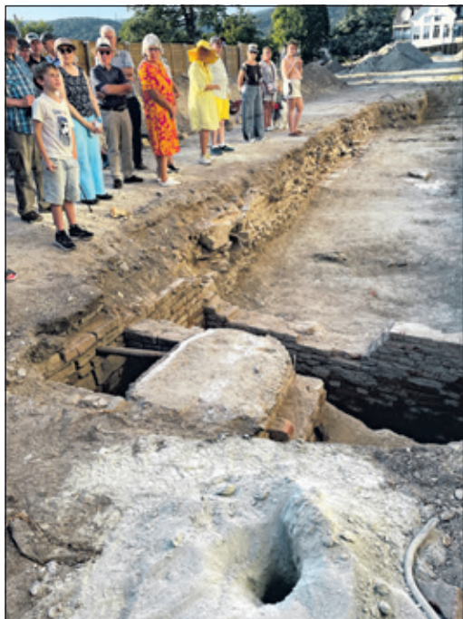
Ein Bohrloch des Kampfmittelräumdienstes und die Mauerreste der Brauerei des Kapuzinerklosters. Hier wird eine Zisterne gebaut.
