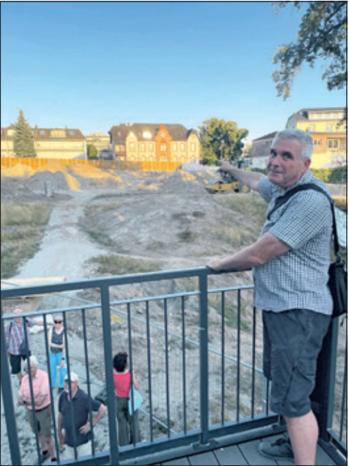
Dahinten wird der Busbahnhof gebaut: Bauamtsleiter Gerd Böhmig auf dem Aussichtspodest an der Georg-Pingler-Straße.
