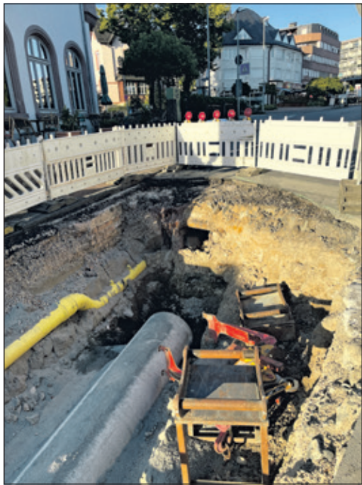
Die aktuelle Baustelle in der Frankfurter Straße mit dem neuen Wasserrohr und darüber dem alten Kanal knapp unter der Fahrbahn.
