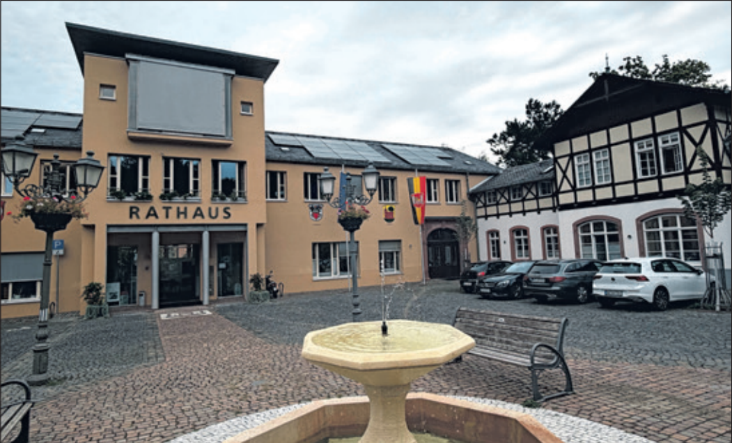
Das Königsteiner Rathaus in neuer Farbgebung, rechts der historische Teil, links der moderne Rathausmittelbau. Die hohen Sockel wurden hier farblich angepasst. Fotos: Stadt Königstein
