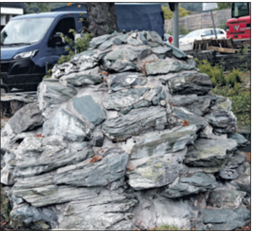
Der Ellesprudel ist stark sanierungsbedürftig.
