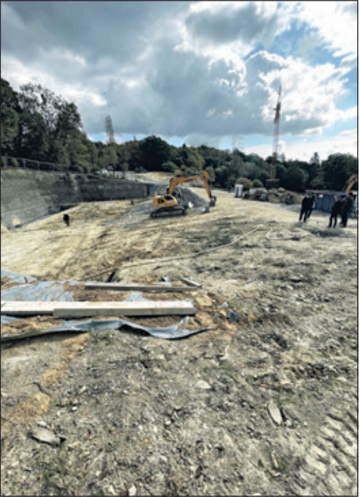
Wo demnächst Panzernashörner und Schabrackentapire ihre Runden drehen: Das 18.000 Quadratmeter große Baufeld samt Kran lässt schon mal die Ausmaße erahnen, die hier für 21 Millionen Euro in Form gegossen werden.
