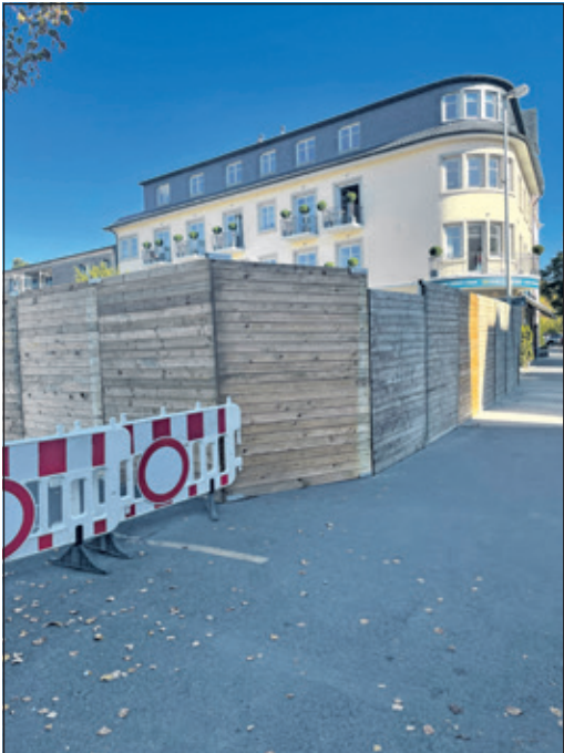
Und plötzlich geht es nicht mehr weiter: Die Einfahrt zum P1 hinter Bretterwand und Barken.
