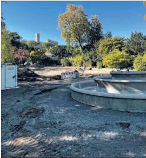
Auch eine Baustelle: Der für viele schönste Teil des Kurparks wartet auf bessere Tage ab 2027.
