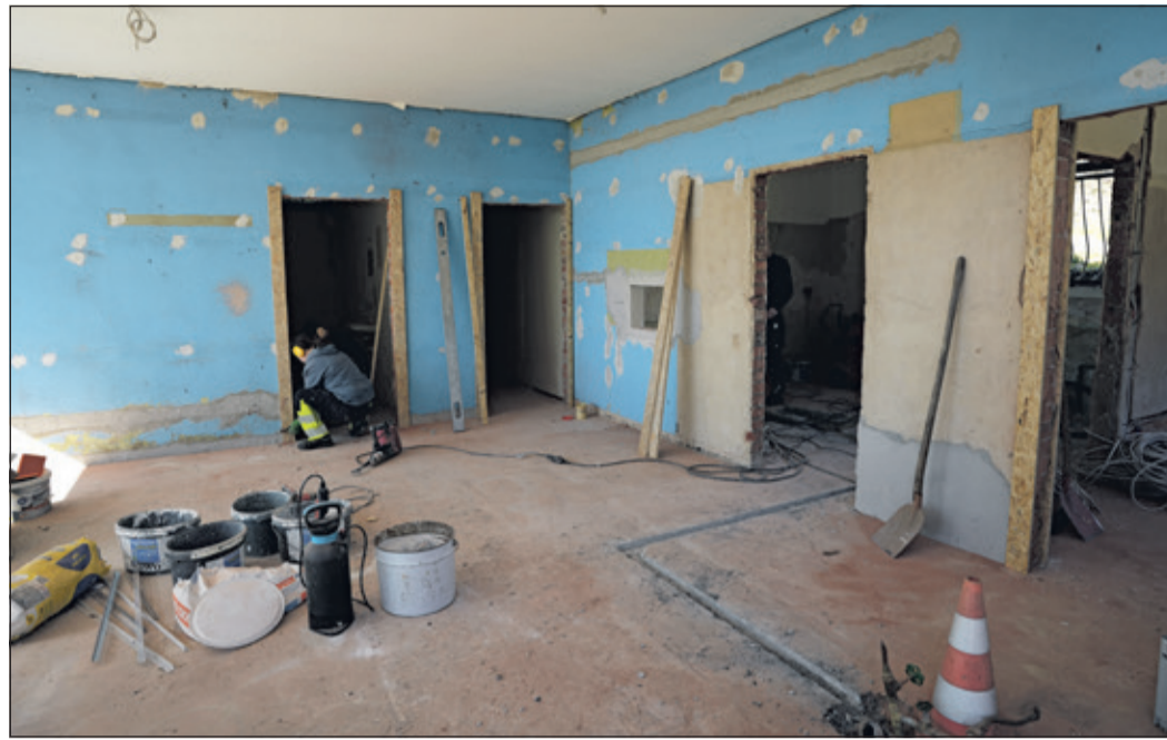
Noch wird die Freibad-Gaststätte umfassend saniert. Ende Mai jedoch sollten die Arbeiten abgeschlossen sein und der Betrieb mit neuem Konzept wieder anlaufen können.
