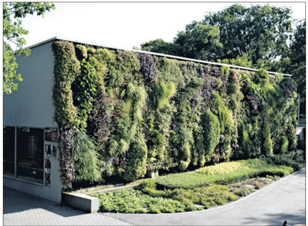
Fassadenbegrünung kann ebenfalls viele Vorteile mit sich bringen.
