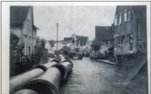
Bereits vor 60 Jahren wurde die Sodener Straße saniert. Fotos: privat
