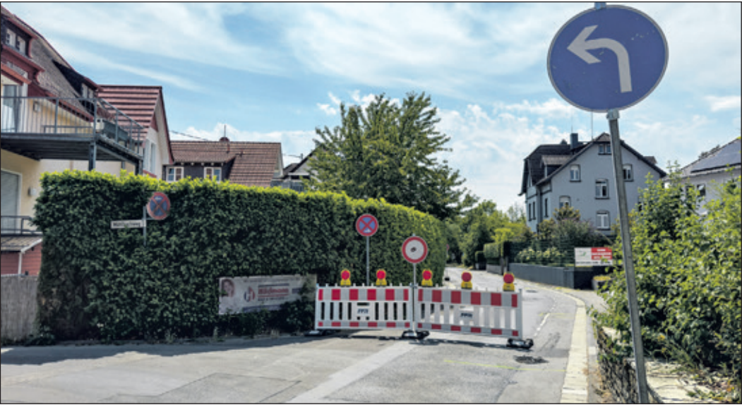
Im ersten Bauabschnitt wird der Teilbereich der Sodener Straße zwischen dem Abzweig des Mühlbachwegs und der Zufahrt zur Landesstraße 3015 saniert. Zu diesem Zweck wird der aus dem Ortskern kommende Verkehr über den Mühlbachweg umgeleitet.
