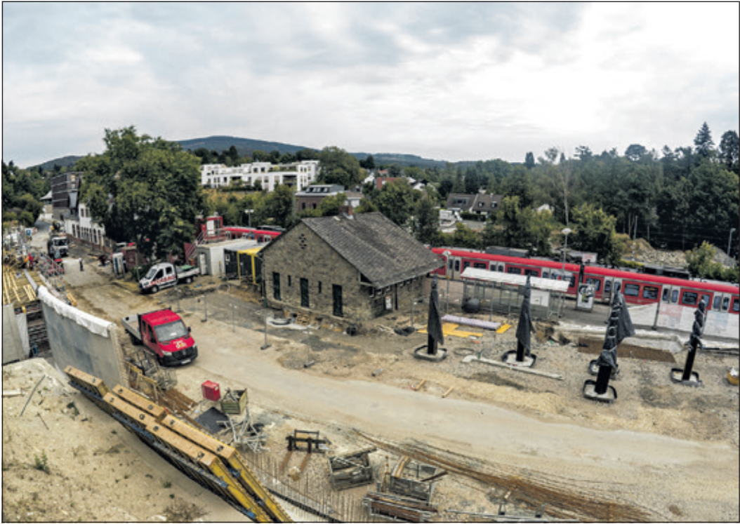
Es geht unübersehbar voran im Kronberger Bahnhofsumfeld. Um Verzögerungen aufzuholen und damit zusätzliche Kosten zu verringern, wird die Bauphase II bereits zum 31. August gestartet.
