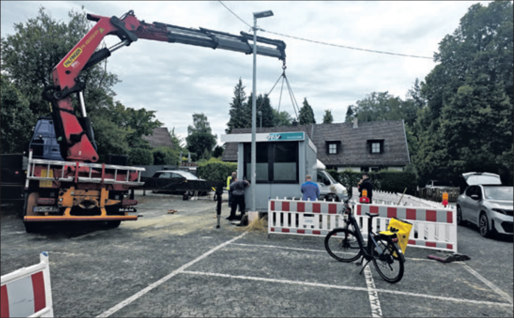
In Vorbereitung auf die Bauphase II wird das Reisezentrum umgesetzt. Unweit der Packstation und der Zufahrt aus Richtung Ludwig-Sauer-Straße werden die Container in den kommenden Monaten zu finden sein. Foto: Stadt Kronberg
