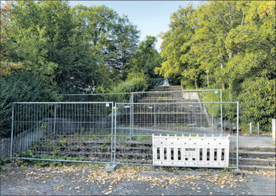
Die Treppenanlage am Friedhof Thalerfeld hat ihre besten Jahre schon einige Zeit hinter sich. Da eine Sanierung zu teuer geworden wäre, wird die Treppe komplett zurückgebaut und der Hang naturnah umgestaltet.
