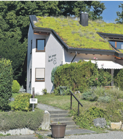
Dachbegrünungen tragen zum Klimaschutz bei: Sie binden CO 2 in der Vegetation und helfen durch Energieeinsparungen, Emissionen zu senken.
