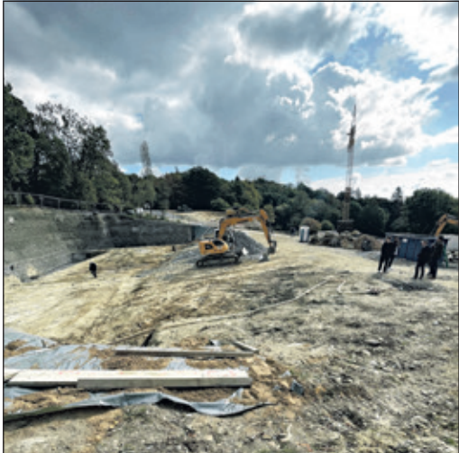
Wo demnächst Panzernashörner und Schabrackentapire ihre Runden drehen: Das 18.000 Quadratmeter große Bau-feld samt Kran lässt schon mal die Ausmaße erahnen, die hier für 21 Millionen Euro in Form gegossen werden. Foto: Glückert
