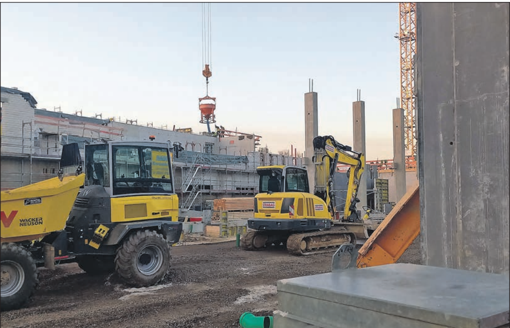
Auf der Baustelle wachsen die Türme in den Himmel. Foto: Streicher
