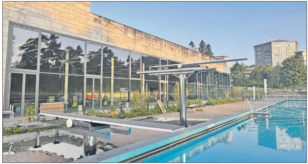
Die neue Sprunganlage für alle sprungbegeisterten Badegäste ist kurz vor der Fertigstellung. Foto: Stadtwerke Oberursel
