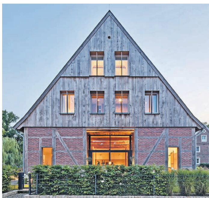
Bei der Sanierung historischer Fassaden, wie hier an einem Bauernhof in Münster, ist viel Fachwissen gefragt. Foto: DJD/Brillux
